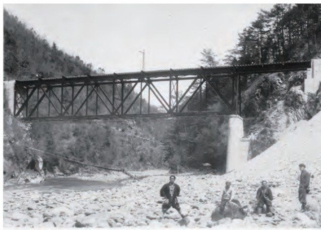
線路鉄橋の工事
