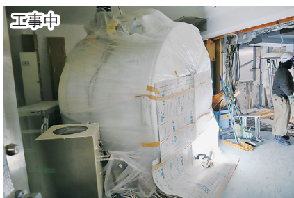
工事中 引き続き使用する電磁石部分を包んで保護しました。
